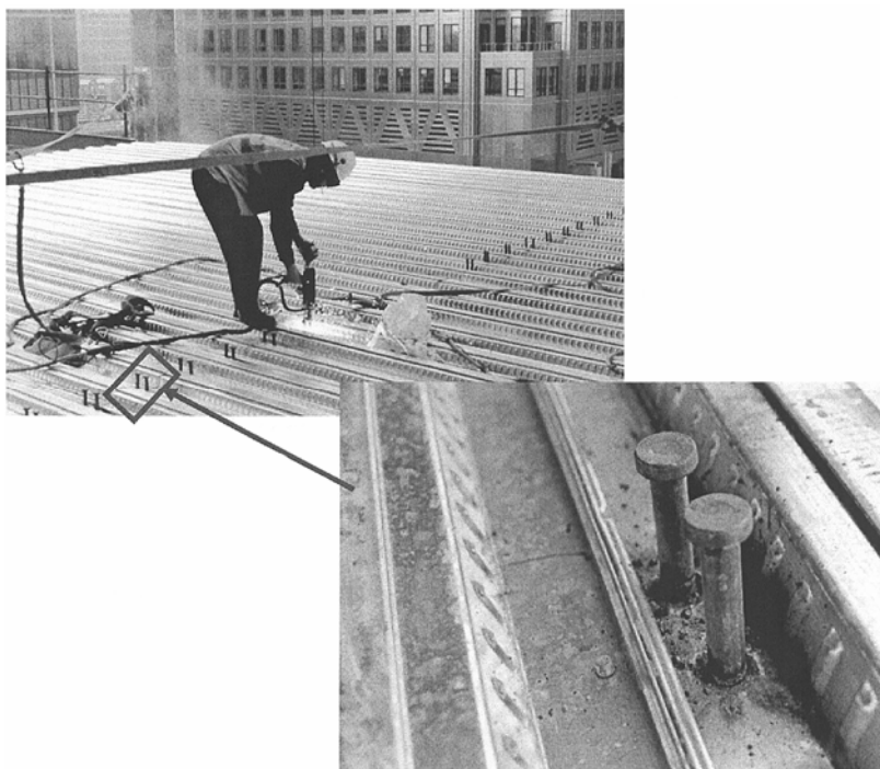
Рисунок 15 – Установка стад-болтов в перекрытии с помощью пистолета
